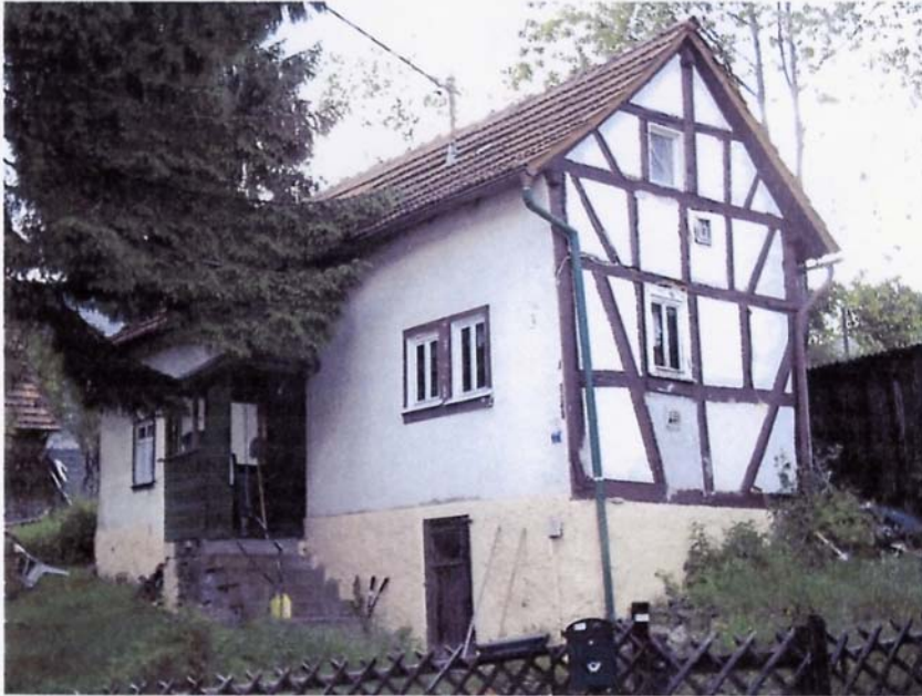
Das Haus hat ein Außenmaß von ca. 11 x 4 mtr.
